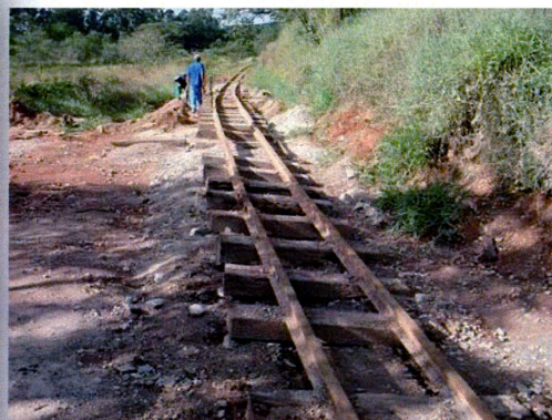
Restauro dos trilhos
