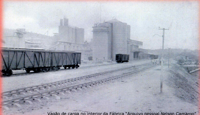
Vagão de carga no interior da Fábrica "Arquivo pessoal Nelson Camargo"
