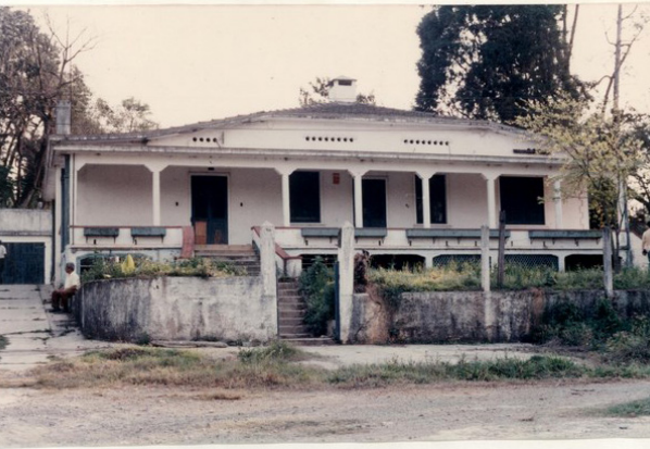
Foto no. 5 - Casa do Admnistrador Geral
