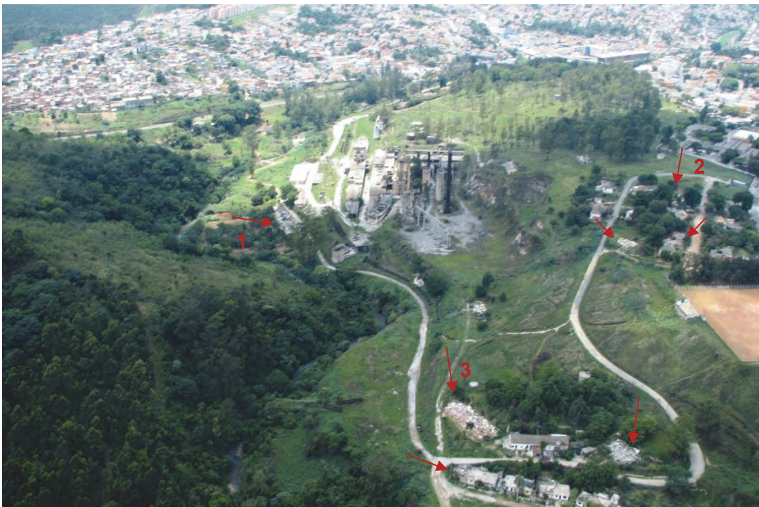
Figura 68: Demolições no conjunto em Perús.
