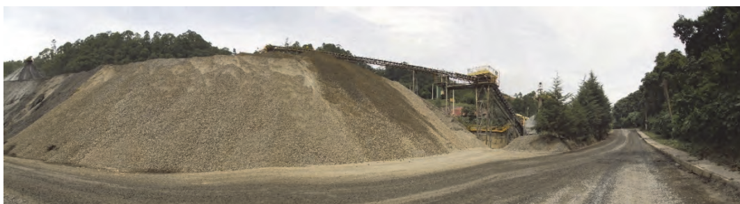
Figura 101: Britador em funcionamento pela Votorantim, em Cajamar.
