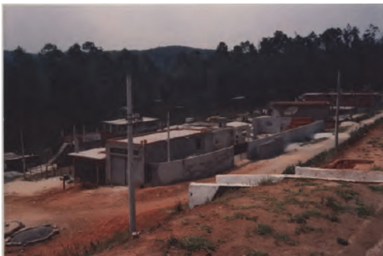
Figura 42: O crescimento de loteamentos clandestinos em área envoltória da EFPP em Cajamar, durante a década de 1990.
