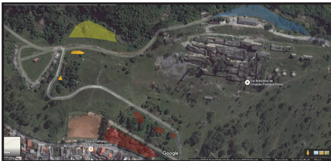
Figura 71: Permanência das instalações industriais em estado precário de conservação.
