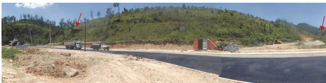
Figura 87: Visão geral de Gato Preto, em 2014. As setas indicam as ruínas do sistema de produção de cal.
