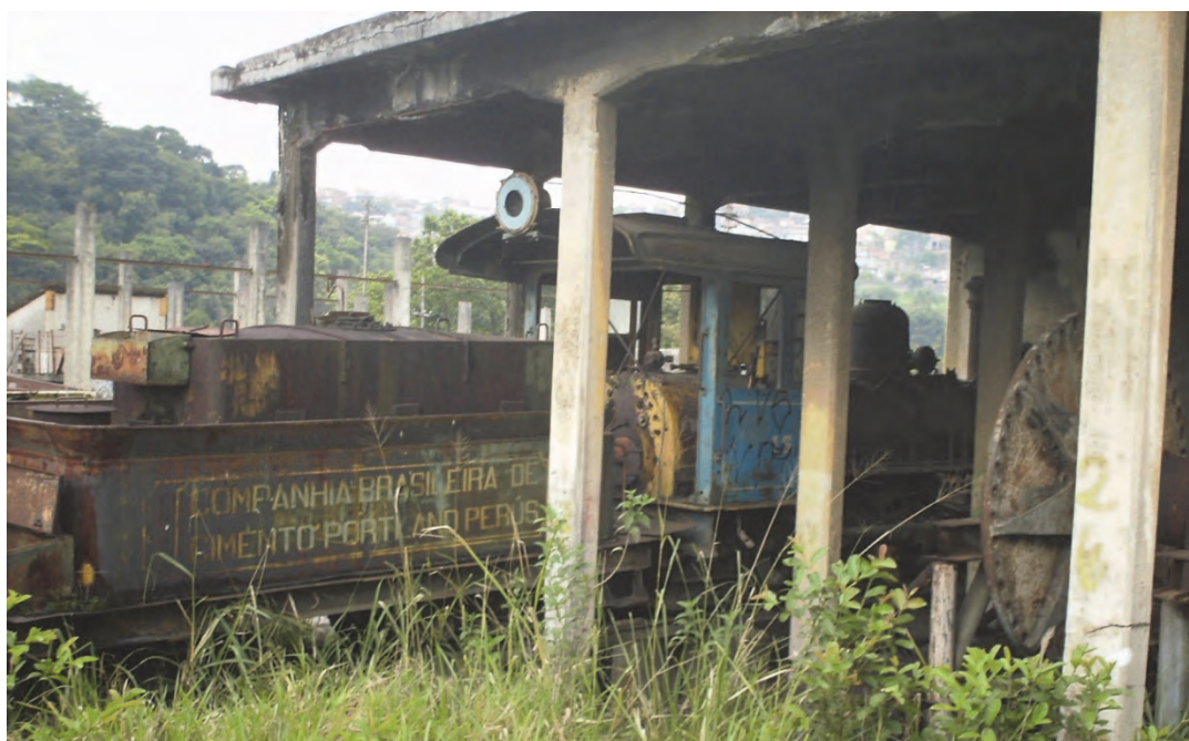
Figura 30: Instalações fabris e material rodante abandonados em Perus.
