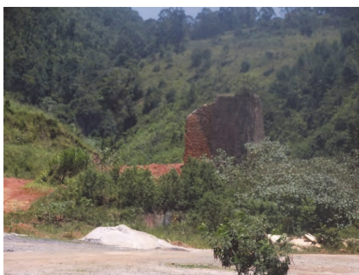
Figura 86: Ruína remanescente do forno de cal, 2014.
