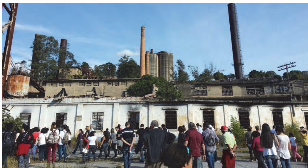
Figura 78: Vista das instalações da fábrica em 2014, durante o Cortejo que foi parte do evento I Caramanchão Cultural na Fábrica de Cimento Perus, que reuniu atividades culturais e festivas no entorno da fábrica, com intuito de relembrar as memórias e lutas dos trabalhadores da fábrica de cimento. Em primeiro plano, as oficinas com elementos arquitetônicos danificados. Ao fundo, a profusão de elementos verticais, entre silos e chaminés, presentes ainda no local.
