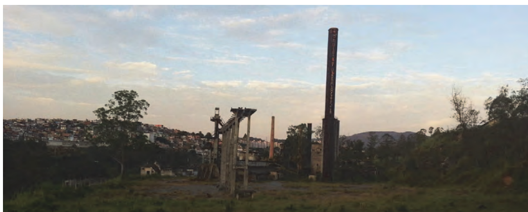
Figura 79: Vista das instalações da fábrica em 2016. Em primeiro plano, a estrutura das esteiras tripper.
