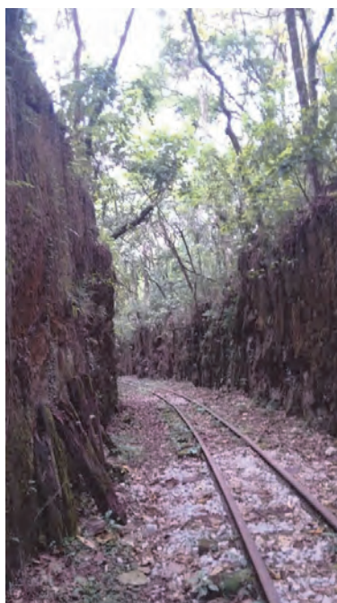
Figura 35: Corte na rocha para passagem da EFPP, em 2016.
