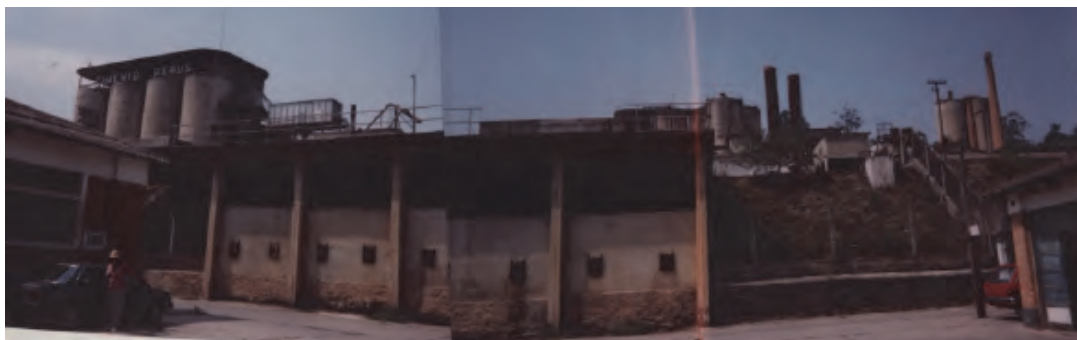
Figura 59: Entrada da Fábrica, próximo ao depósito. Ao fundo, à esquerda, destaque dos silos e ensacadeira, década de 1990. Fonte: Condephaat, 1980.
