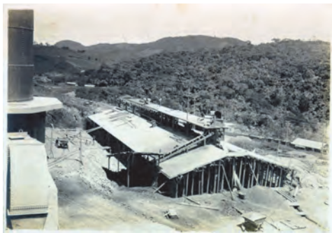
Figura 4: Instalações industriais em construção.
