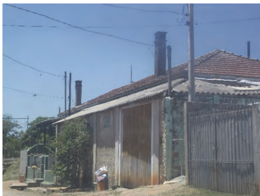
Figura 94: Anexos construídos nas casas de Vila Nova com chaminés.
