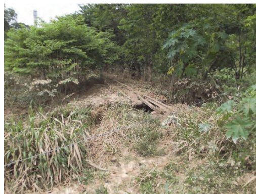
Figura 49: Estado precário de conservação dos trilhos da EFPP. Ao fundo, lado esquerdo, observa-se a caixa d'água da empresa Natura Cosméticos.
