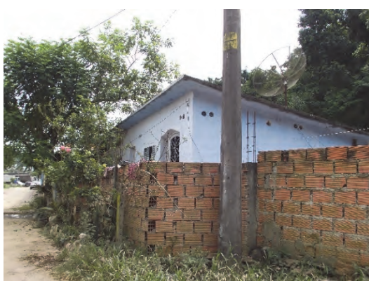
Figura 98: Casa em Gato Preto com detalhes do sistema de ventilação.
