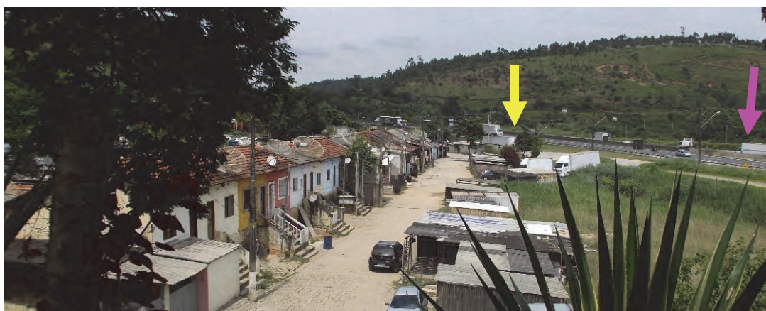
Figura 38: Parte da Vila de Gato Preto, segregada do conjunto.
