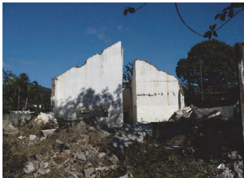
Figura 32: Edifício da Pensão do Portland, em demolição.
