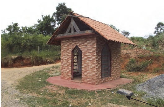
Figura 92: Parada do km 12, reformada.
