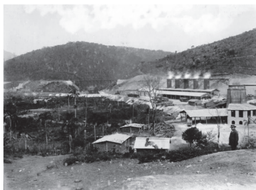
Figura 21: Instalações de Gato Preto, 1914. Em primeiro plano as oficinas; logo após o grande forno de cal, seguido de cinco outros fornos metálicos. À esquerda, o único viaduto que a Perus-Pirapora possuiu.
