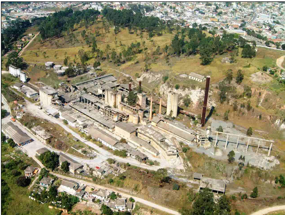
Fábrica de Cimento Portland Perus (2002)
